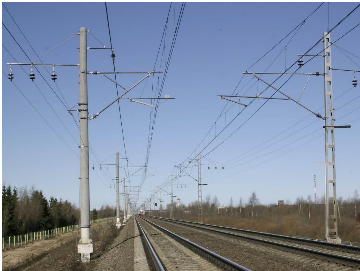
Рис. 2. Контактная сеть КС-200 на линии Санкт-Петербург – Москва
