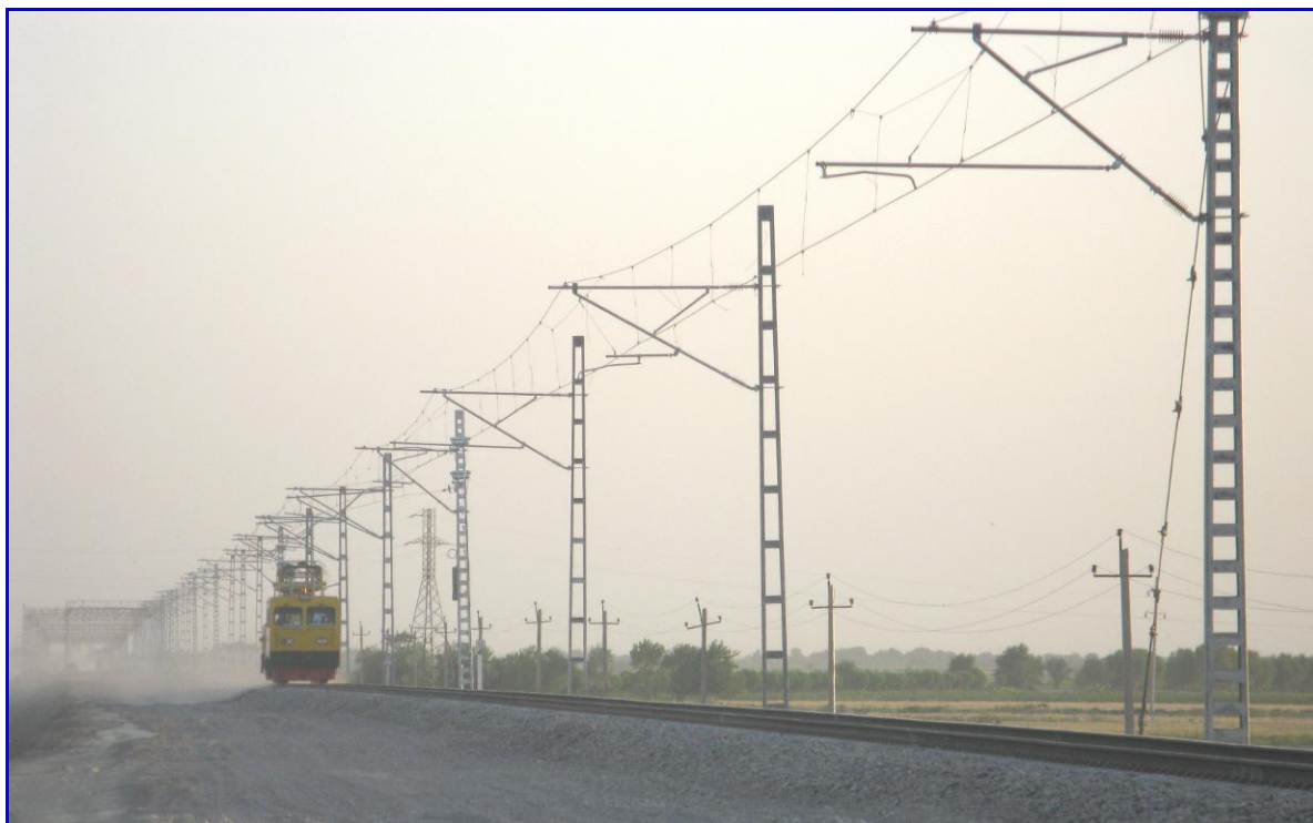
Рис. 7. Контактная сеть КС-250-25-UZ в процессе монтажа
